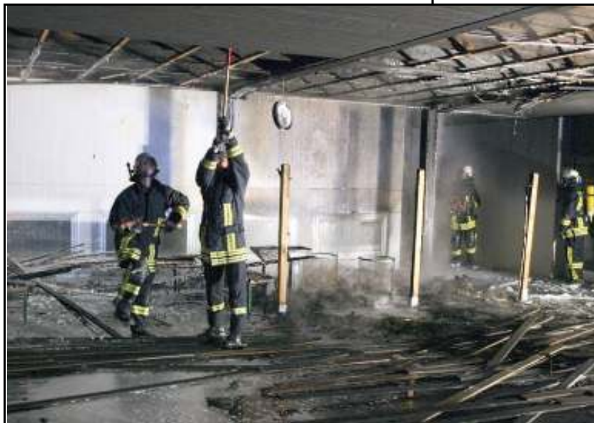
Die Deckenkonstruktion wird mittels Feuerwehrtaxt eingeringt.
