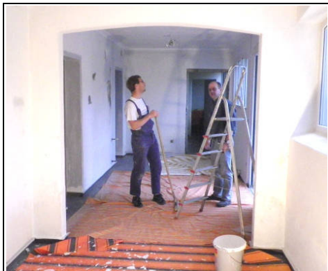
02.09.2014 – Matthias Neiding beim Deckenanstrich
