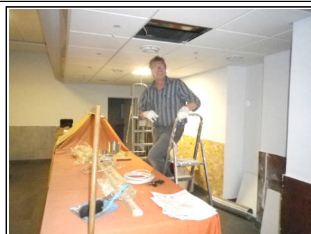
21.10.: Uli Greschniok arbeitet an der Lüftung.
