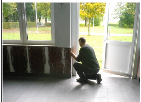
13.10.: Heinz Ewald verlegt Linoleum.
