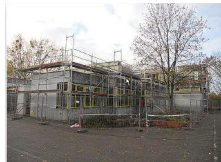
Fingertafel Fassade des Verwaltungstraktes Bild 1 von 7
