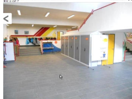
Eingangshalle mit neuem Bodenbelag und Abstellraum unter der Treppe Bild 3 von 7
