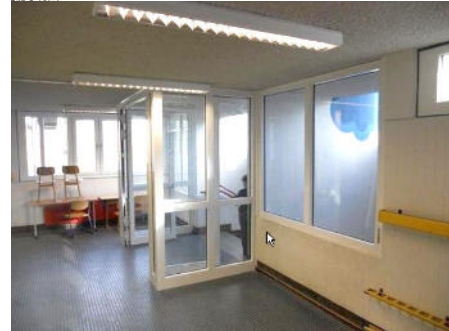
Treppenhausabschottung/neuer Bodenbelag Bild 6 von 7
