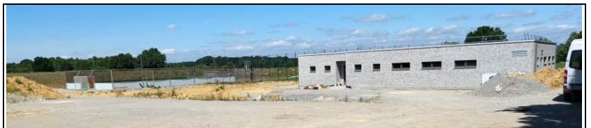
Das Sportzentrum ist funktionsfertig. Der Spielbetrieb kann aufgenommen werden. Das Außengelände bedarf noch einigen Arbeitsaufwand.
